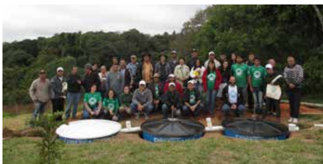
Equipe do projeto Plantando Águas e agricultores após a instalação de fossa séptica biodigestora em propriedade de Piedade (SP).
