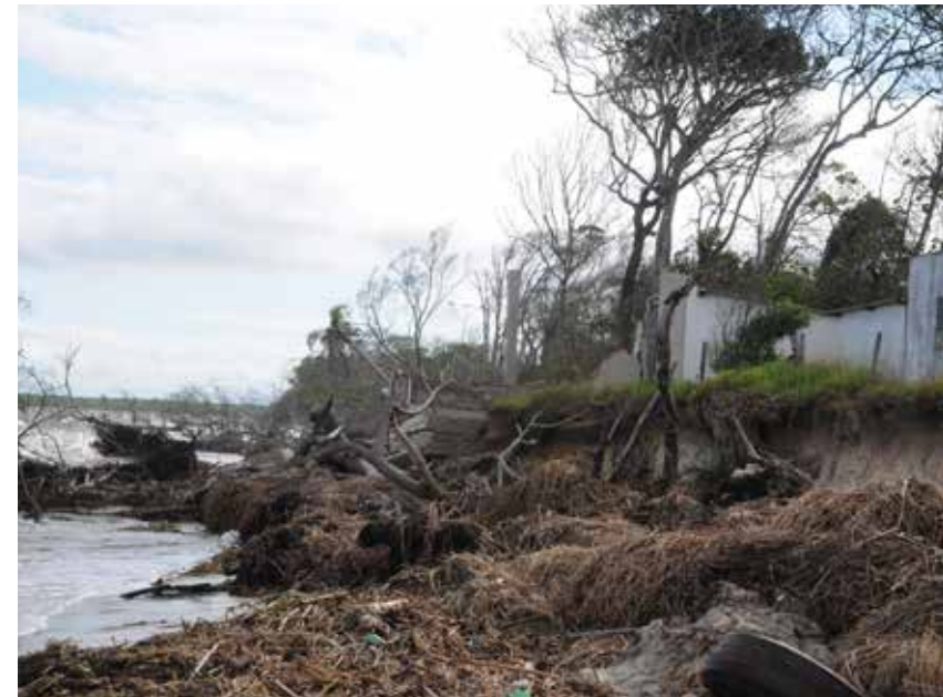
Erosão em área costeira da região do Lagamar (SP).
