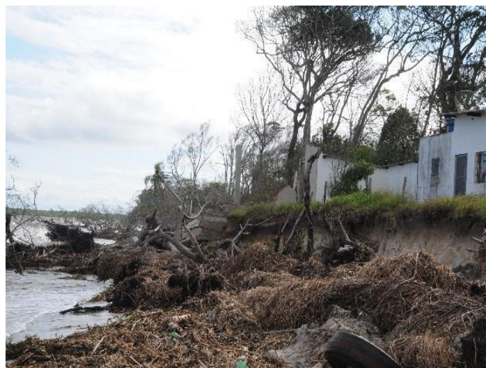
Figura 10 - Erosão avançada na Praia do Leste, com recuo de cerca de 400 m da costa e destruição de edificações.
