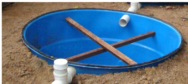
Figura 8. Cruz de madeira para evitar deformação da caixa de fibra de vidro.
