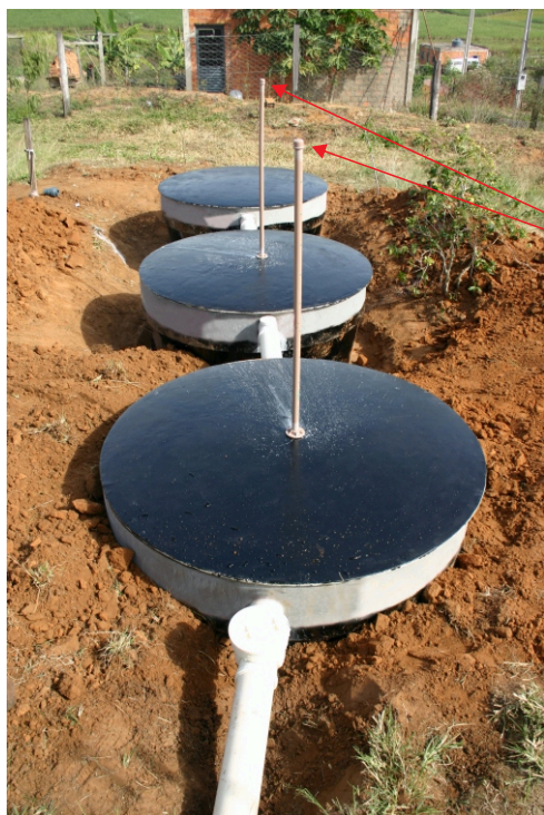
Figura 6. Fossa Séptica Biodigestora com destaque para sistema de alívio de gases.
