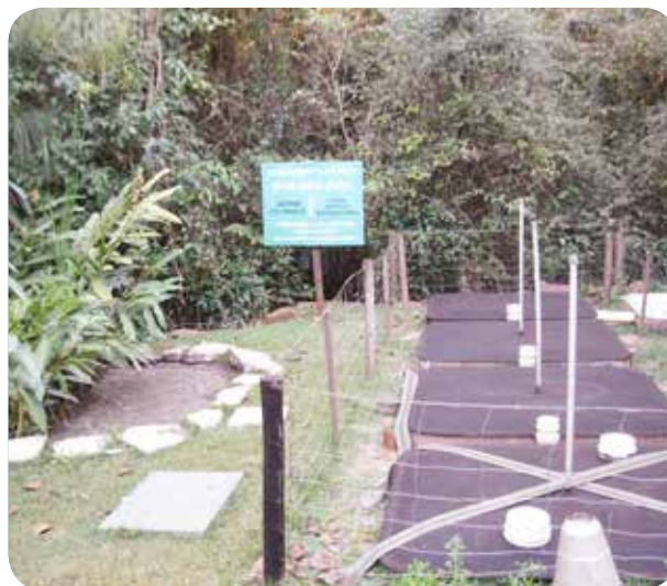
Os visitantes podem conhecer duas tecnologias sociais de saneamento básico: a Fossa Séptica Biodigestora e o Jardim Filtrante.
